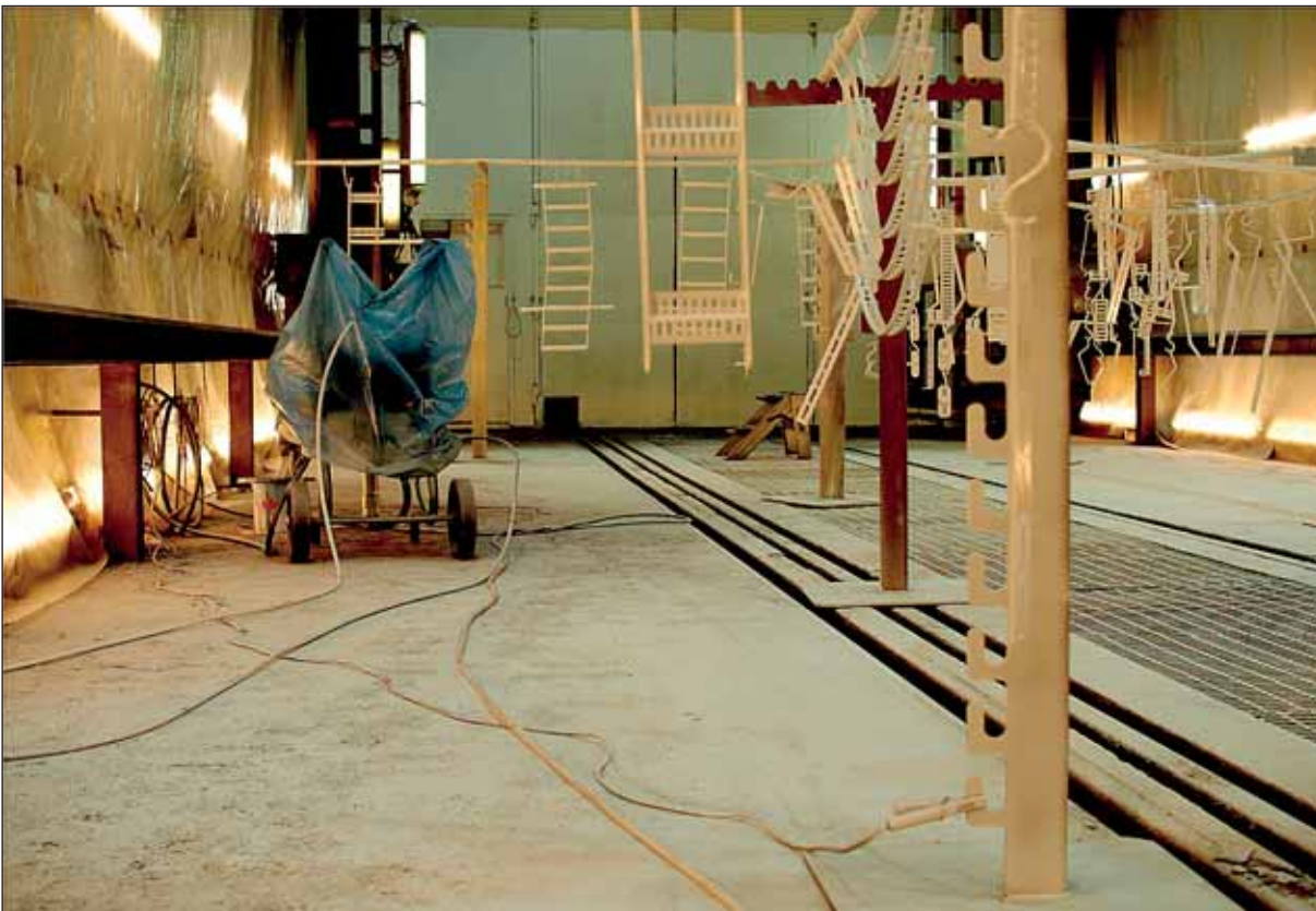
Kuva 1: Yleiskuva maalaamosta korjaustöiden jälkeen. Onnettomuus sattui kuvasta katsottuna maalaamon vasemmalla puolella, lähellä korkeapainemaaliruiskua.
